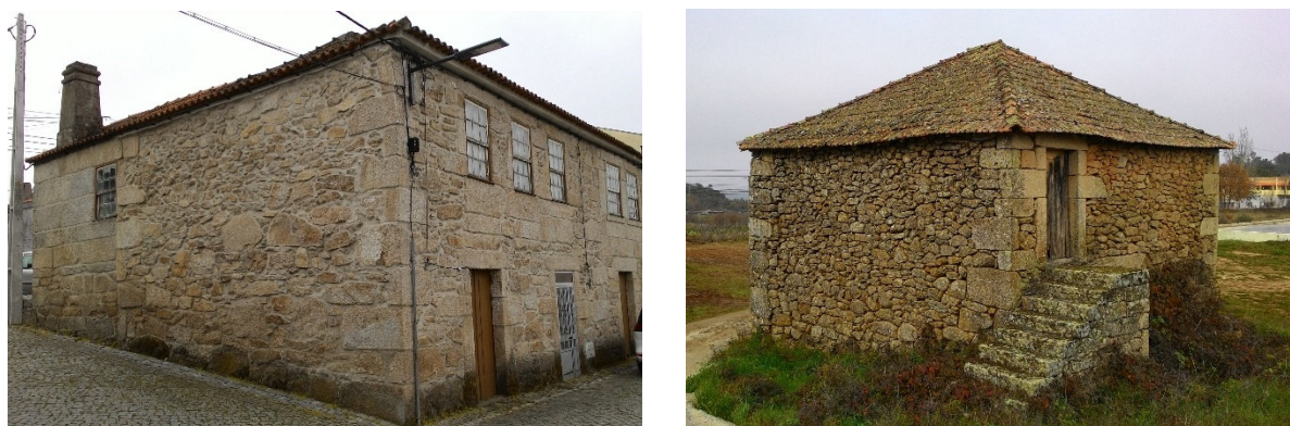
Figura 82: Exemplos de paredes exteriores em alvenaria no Centro Urbano da Vila de Sernancelhe
