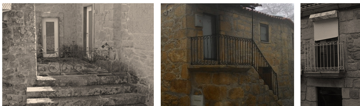
Figura 79: Exemplos de elementos em ferro no Centro Urbano da Vila de Sernancelhe
