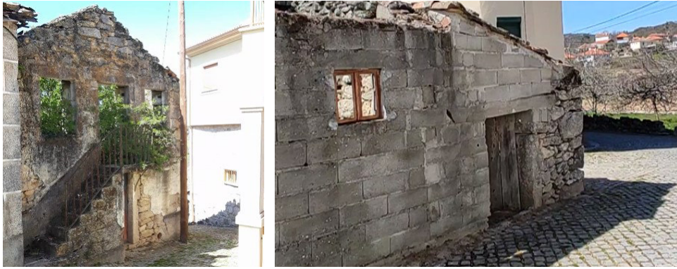
Figura 35 – Edifícios em péssimo estado de conservação, à esquerda: Rua de São João; e à direita: Edifício 239.
