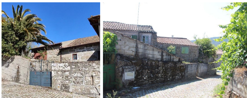
Figura 33 – Edifícios em médio estado de conservação, à esquerda: Rua da Igreja; e à direita: Rua do Soitinho.
