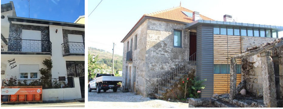
Figura 24 – À esquerda: Habitação e comércio (EM582-1); e à direita: Habitação combinada com um Alojamento Local (Agromanas).
