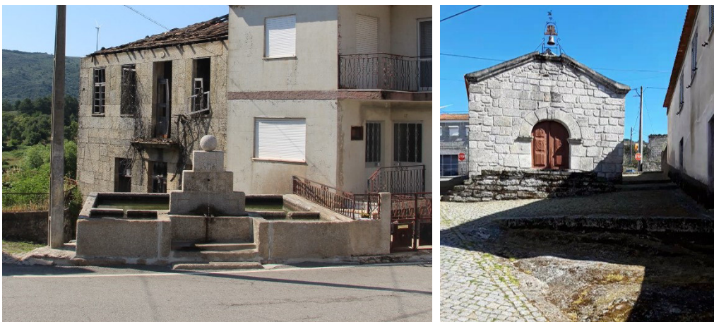
Figura 42 – À esquerda: Largo adjacente à EM582-1 associado a um fontanário; e à esquerda: Largo da Capela de São João Baptista.
