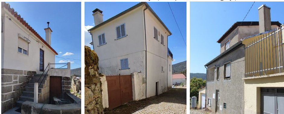
Figura 32 – Edifícios em bom estado de conservação, à esquerda: Rua de São João; ao Centro: Rua da Era; e à direita: Rua do Soitinho.
