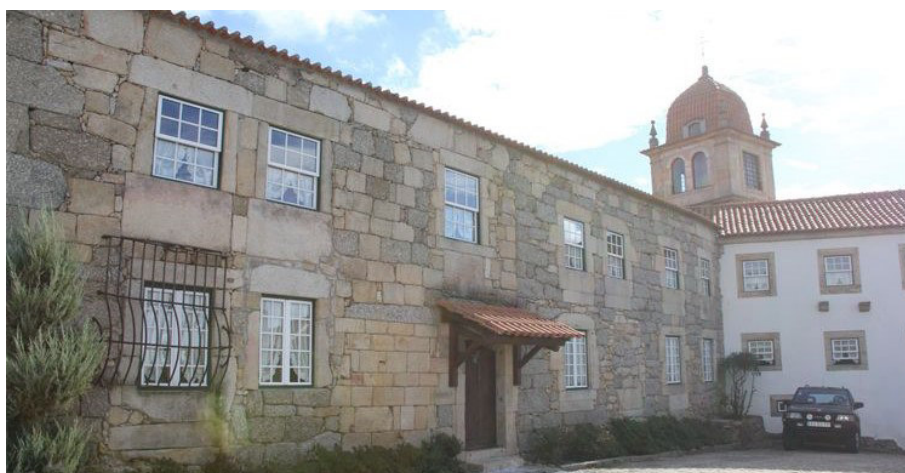
Figura 18 – Recolhimento Nossa Senhora do Carmo.
