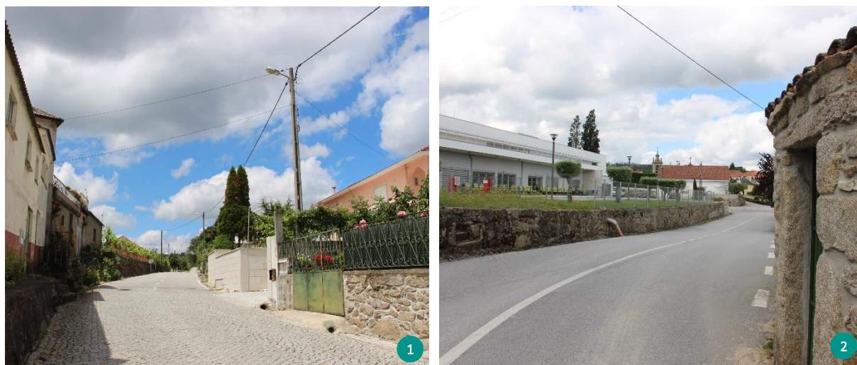
Figura 10 – Rede viária: arruamentos de acesso ao Carregal 1 – Estrada Municipal EM581; 2 – Caminho Municipal CM 1204 (Rua do Eido) Fonte: Cotefis, 2019
