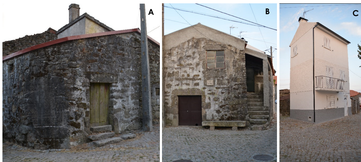
Figura 15- Exemplos de edifícios com diferente número de pisos: A – 1 piso; B – 2 pisos; C – 3 pisos
