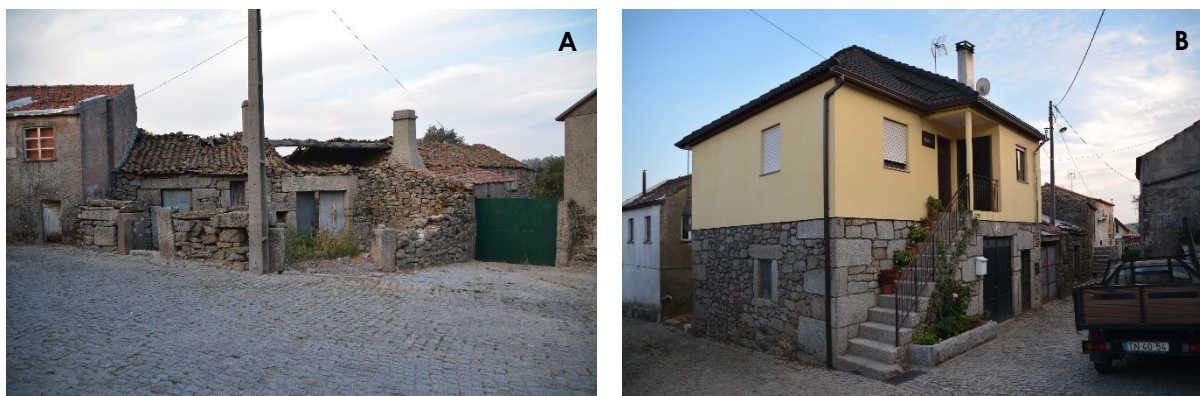
Figura 23- Materiais usados nas coberturas: A – Telha cerâmica natural; B – Telha cerâmica em preto
