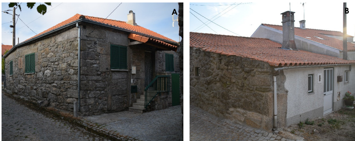
Figura 21- Habitações em granito (A) e granito com betão (B).
