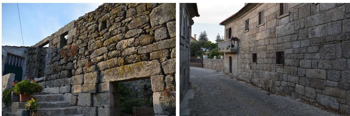
Figura 41- Exemplos de paredes exteriores em alvenaria em pedra em Quintela
