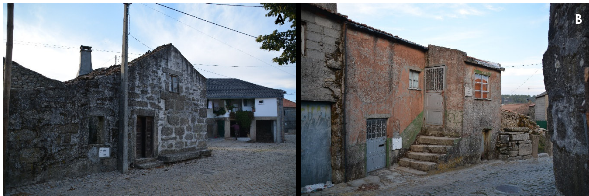
Figura 22- Materiais usados nas portas e janelas: A – Madeira; B – alumínio.
