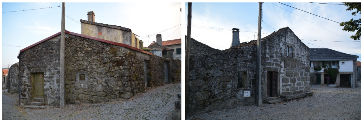
Figura 37- Exemplos de portas e janelas em madeira em Quintela
