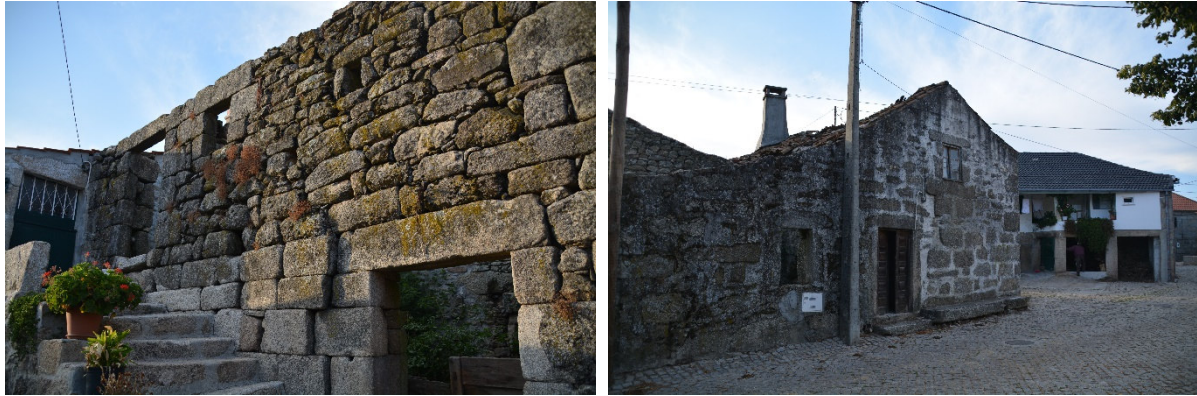
Figura 39- Exemplos de assentamento tradicional de alvenaria em pedra em Quintela
