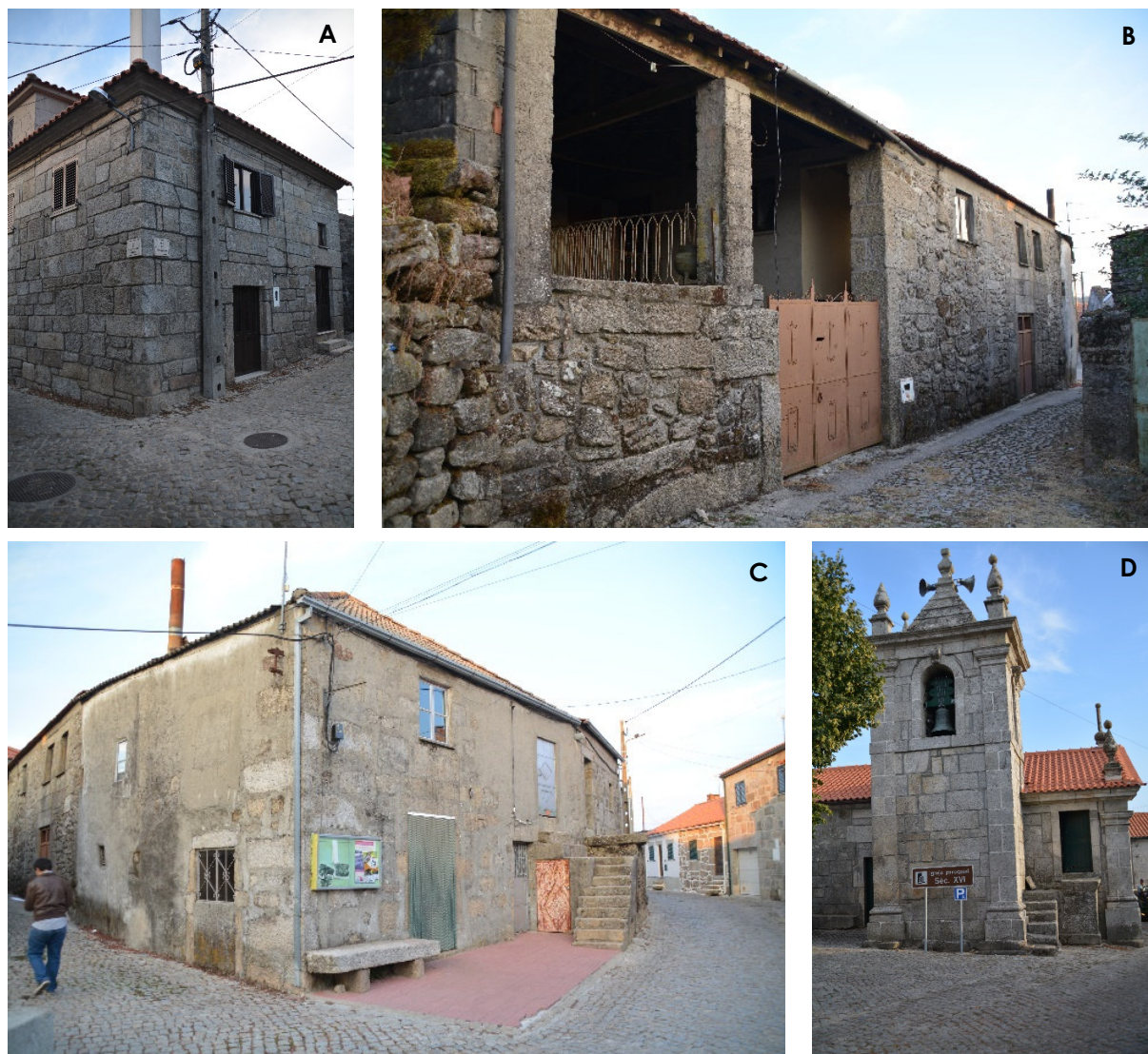
Figura 17 - Exemplos de diferentes usos do edificado: A – Uso habitacional nos dois pisos; B – Uso habitacional no piso superior e arrumos e anexos no piso inferior; C – Uso habitacional no piso superior e comércio no piso inferior; D – Equipamento de culto - igreja
