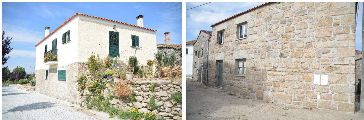
Figura 19: Edifícios em excelente estado de conservação: Rua da Amoreira e Rua de Santa Quitéria
