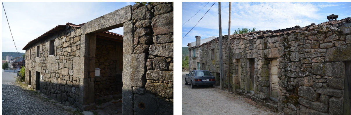
Figura 41: Exemplos de assentamento tradicional de alvenaria em pedra na Aldeia de Santo Estêvão
