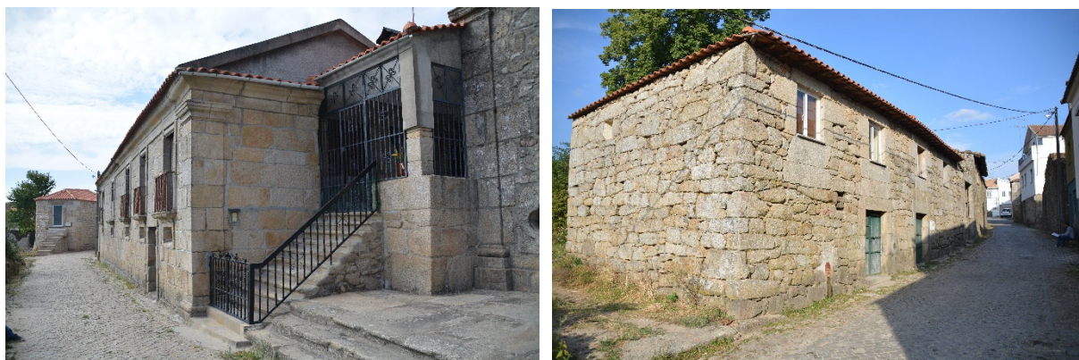
Figura 20: Edifícios em bom estado de conservação: Rua de Santa Quitéria e Rua da Amoreira
